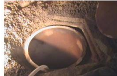
源泉は98℃。水で薄めて給湯する。
