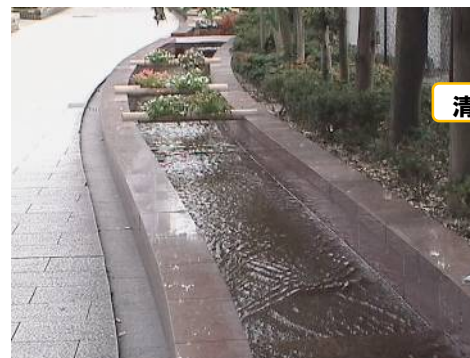
流水路は約1000mある。
