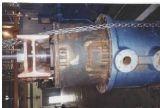
Coolor 解体作業
